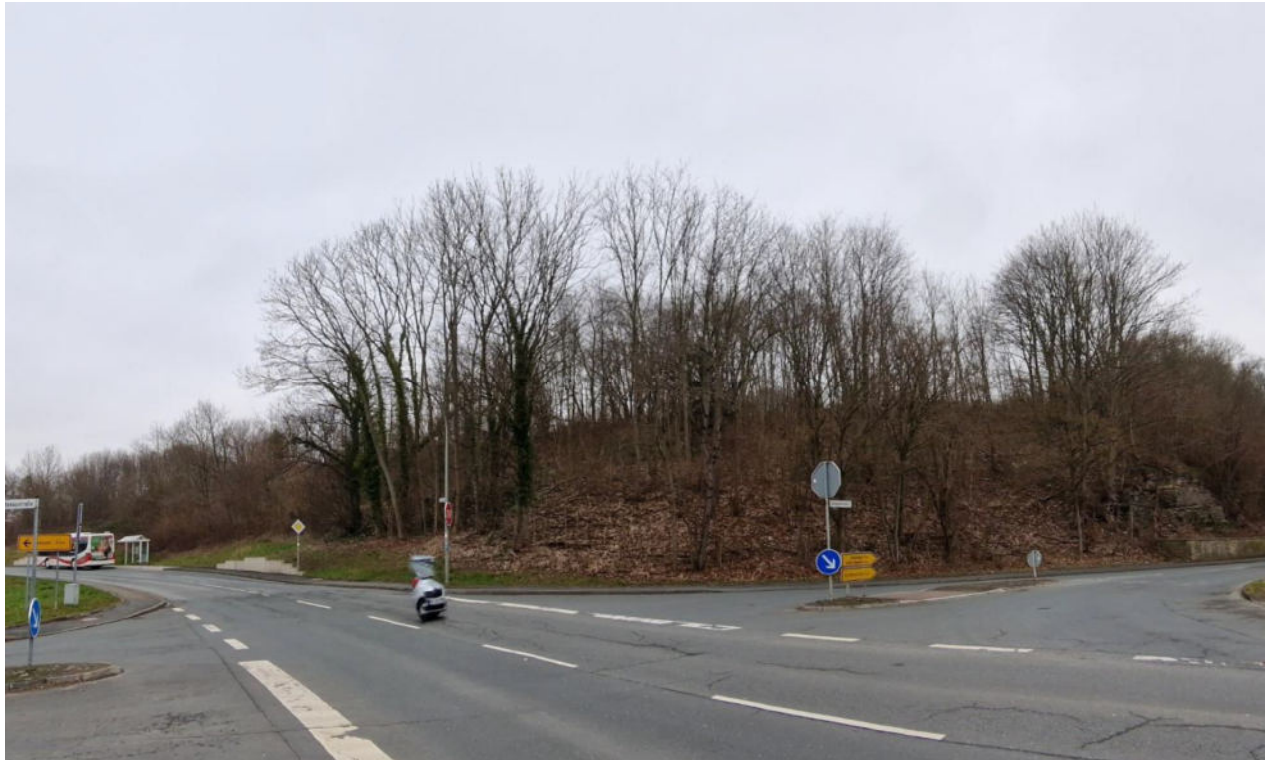
Abbildung 1 Blick auf das Plangelände vor der Sanierung der Paderborner Straße
