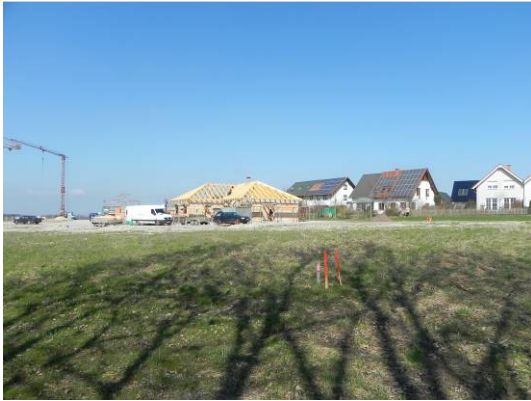
Abb. 9 Neue Wohnbebauung im Baugebiet „Am Kirchpade II“.
