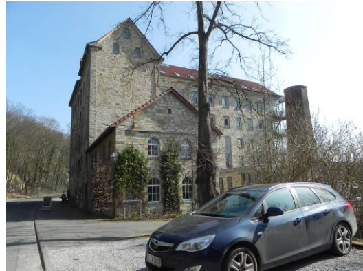
Abb. 10 Gebäude der Lippemühle südlich der Erweiterungsfläche.
