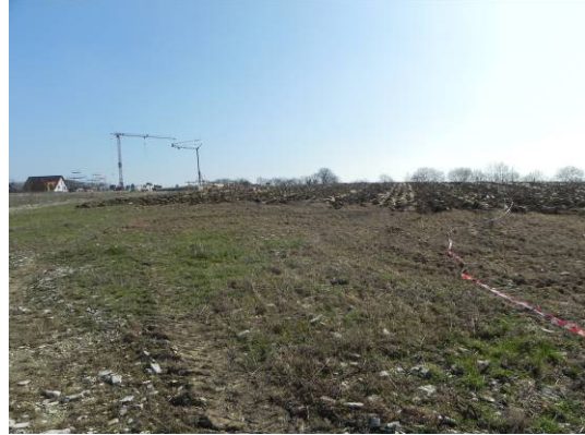
Abb. 6 Blick über die Erweiterungsfläche aus nördlicher Richtung.
