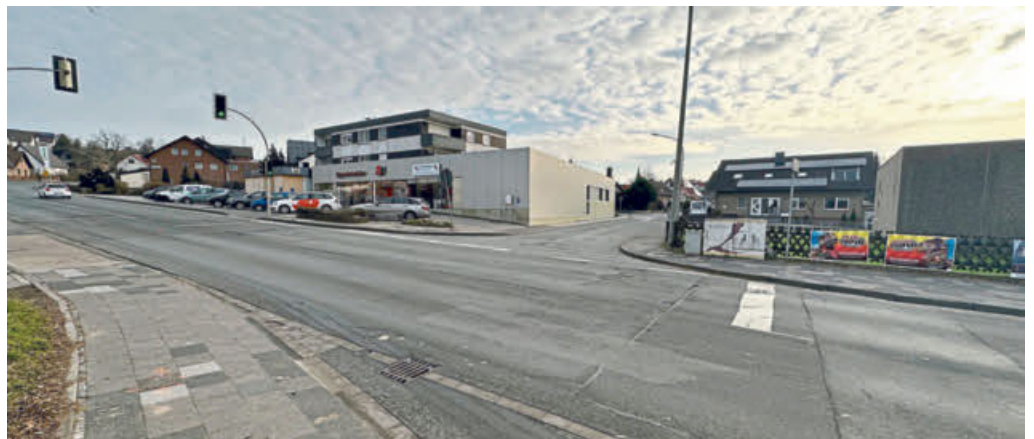
Im Ortsteil Nordborchen wird der Mischwasserkanal erneuert. Die Baumaßnahmen werden voraussichtlich im August 2023 abgeschlossen sein.
