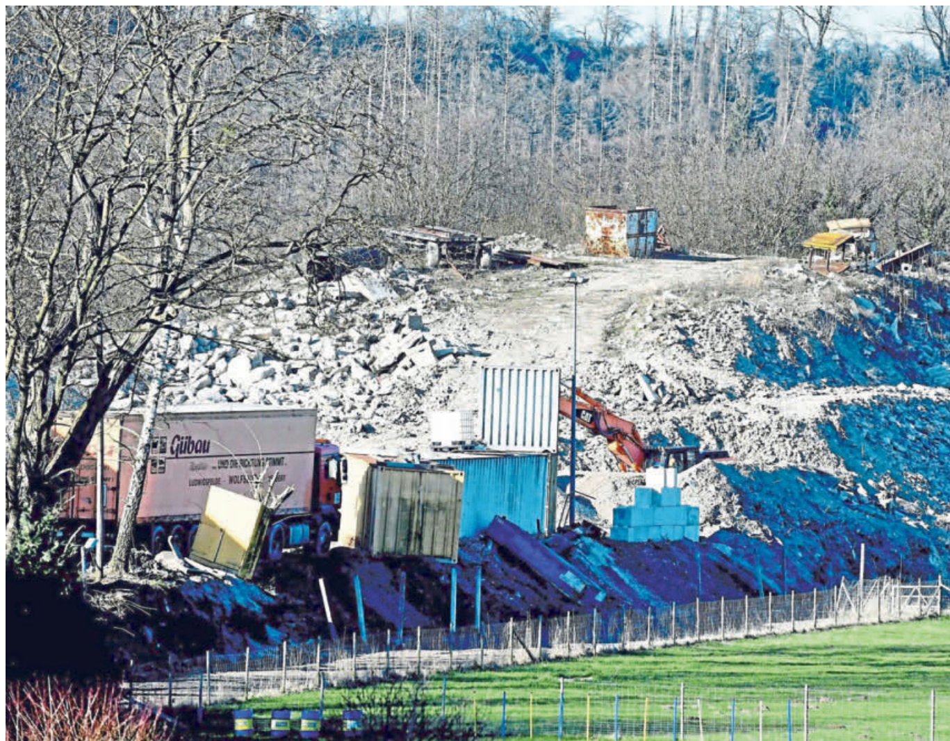
Bagger sind an der Bahnhofstraße in Borchen damit beschäftigt, den dort abgelagerten Schutt abzufahren.
